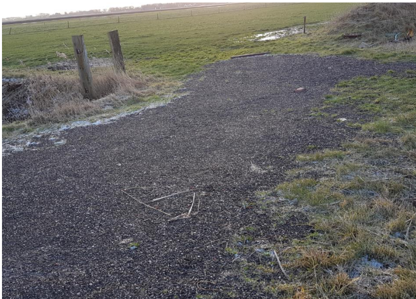
Dam 28: Puin / asfaltverharding
