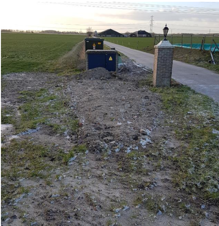
Dam 15: Extra puin aangebracht bij betonpad
