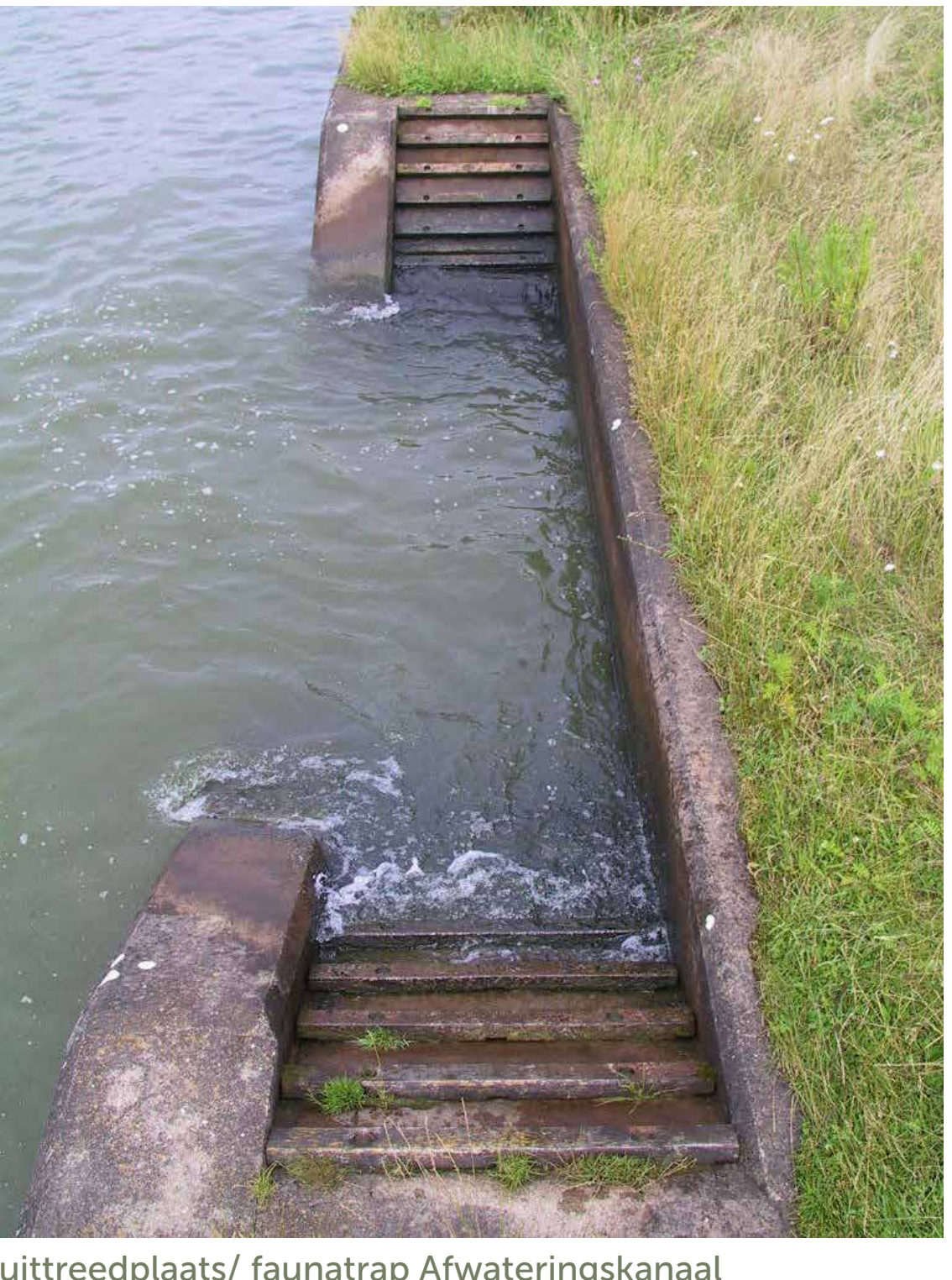
uittreedplaats/ faunatrapp Afwateringskanaal
