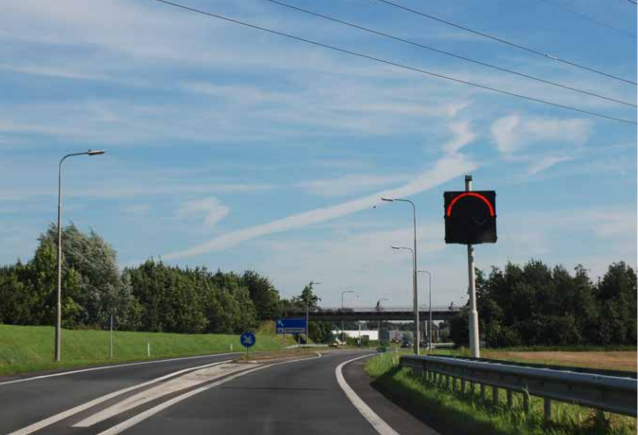
te verwijderen viaduct Holveg
