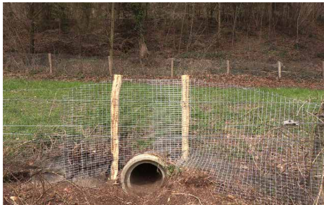
dassentunnel met raster (klaverblad A7 - Scheemderweg)
