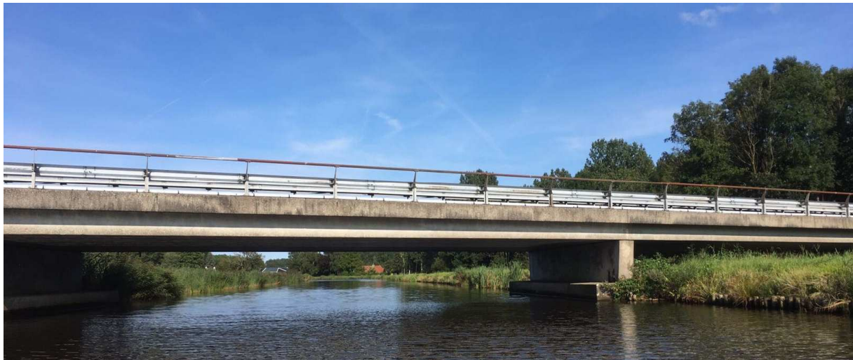
Huidige brug N33 over het afwateringskanaal bij Tjuchem
